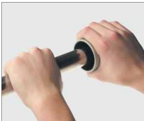
■ Снятие фаски с торцов трубы.
