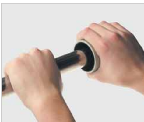
■ Снятие фаски с торцов трубы.
