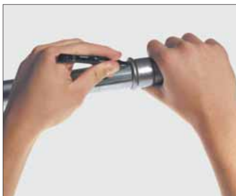
■ Отметка требуемой глубины вставки.
