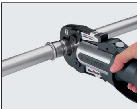
6. Опрессовка соединителя на трубе
