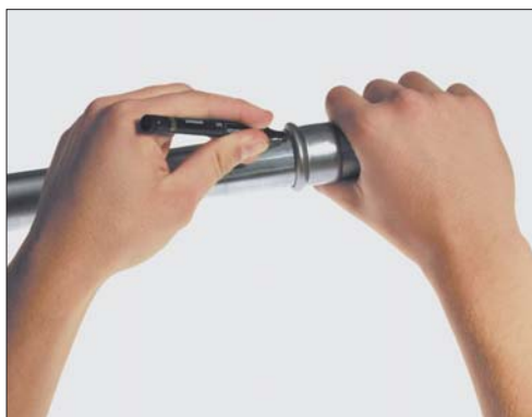
3. Отметка глубины вставки трубы
