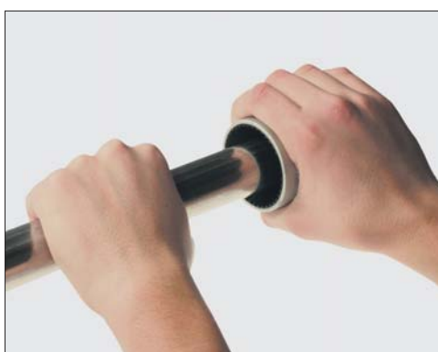
2. Снятие фаски с торца трубы
